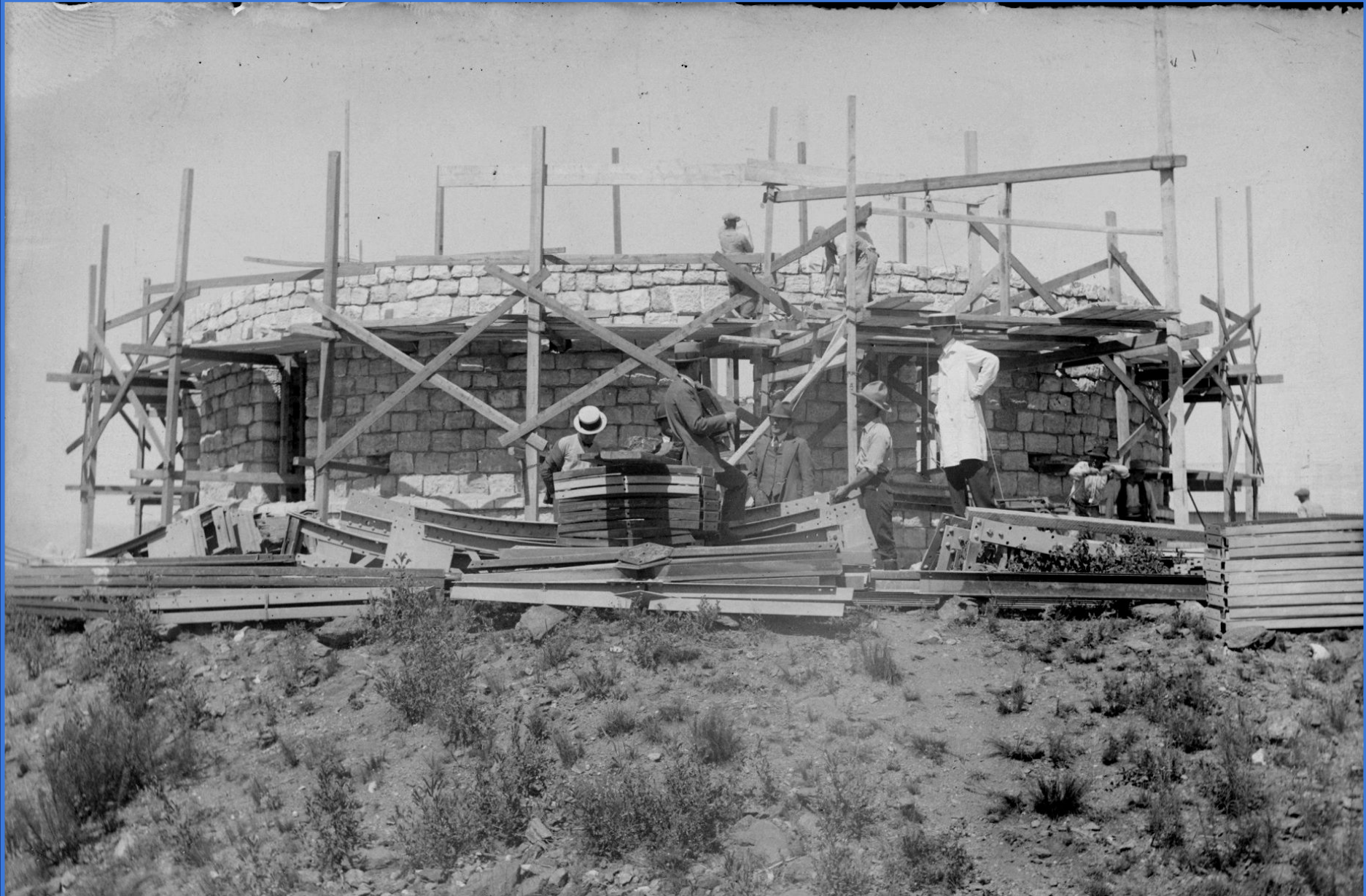
Construcción cúpula principal Estación Astrofísica de Bosque Alegre. 1929.
