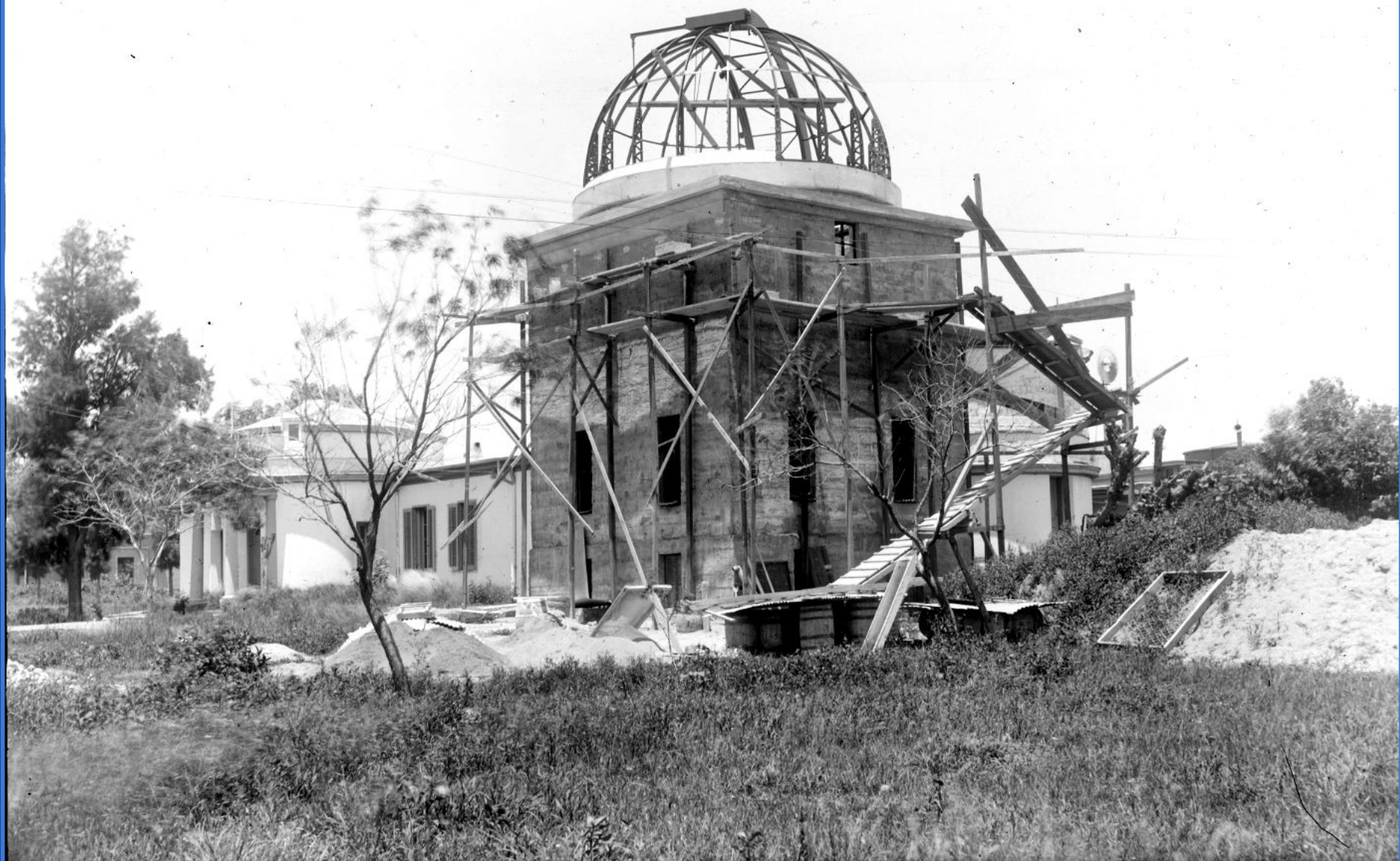
Construcción del nuevo edificio en Córdoba. 1912.
